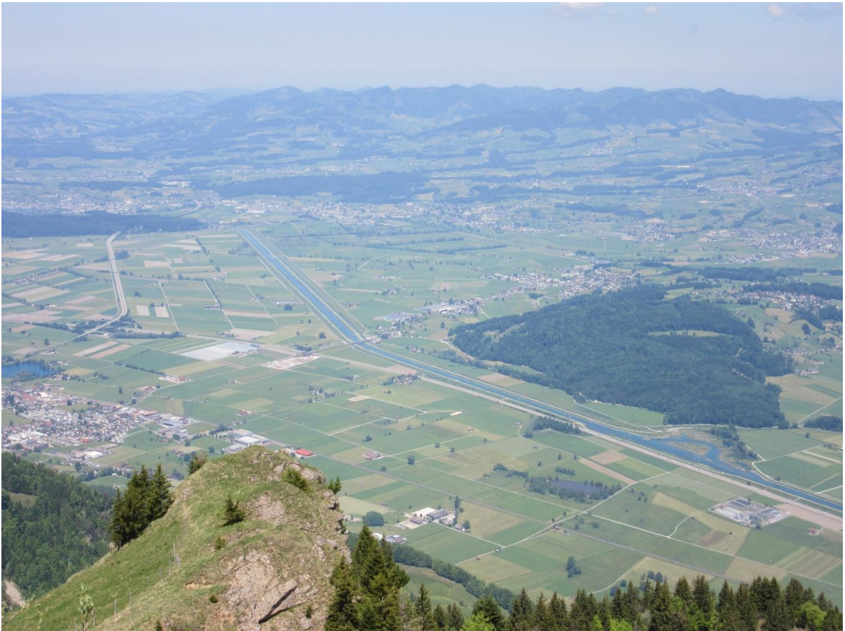
Der Linth Kanal
